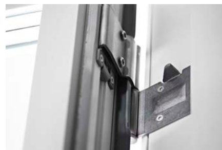
Hængsler med indbrudssikring
